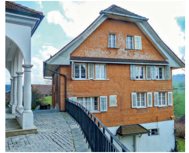
Sanierungsbedürftig: das Pfarrhaus Geiss. Bild: Kirchgemeinde
